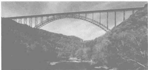
图 1-11 新河峡谷大桥
