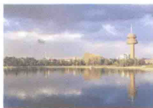
沈阳东软软件园
