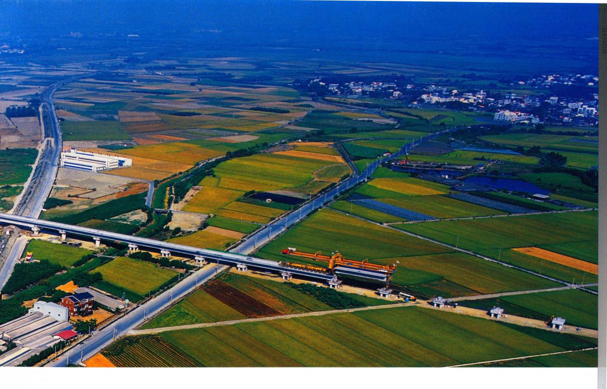
軌道工程採設計與施工合一之發包方式辦理共分T200、T210、T220、T230及T240等5個標。全線345公里,除左營車站約3公里路段,採道碴軌道舖設外,其餘均採用道版軌道舖設。由國外營造廠商以聯合承攬方式 辦理,於91年6月開工,並於94年6月完工。其中T240標之範圍涵蓋試車線路段,T200標為台北市區鐵路地下化隧道段(包括台北站及板橋站)。基地工程包括汐止、六家、烏日、太保及左營基地與燕巢總機廠等6座。除 了燕巢總機廠主要負責車輛修理,其餘5座基地主要提供工務與電務維修服務以及車輛之調度。在營運初期,燕巢總機廠及六家、烏日、太保、左營4座基地先行配合運作;汐止基地則將配合實際使用之需求再行興建。
