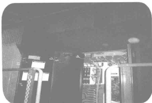
图 1-3 HXN 5 型内燃机车辅助/逆变室
