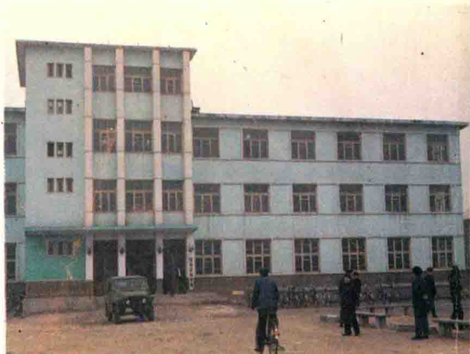
灯塔县局办公楼
