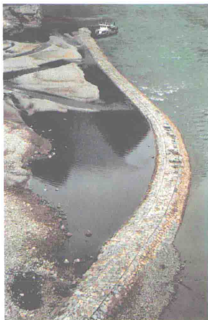
航道整治工程
