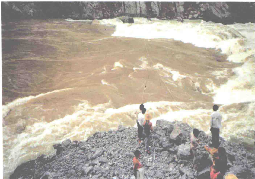
四川省交通厅内河勘察规划设计院在乌江岩崩抢险航道整治中独创的“山区河流急流滩超声波轻缆悬测水深法”，极大节省了抢险工程的时间和资金
