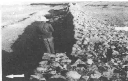
宁夏银川红果子沟口外明代长城被 1739 年地震右旋错断遗迹 (1965 年, 左时振梁摄、右环文林摄)
