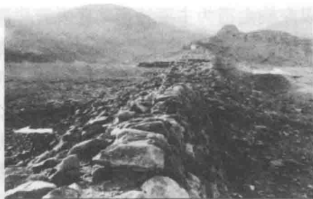
宁夏银川红果子沟口外明代长城被 1739 年地震右旋错断遗迹 (1965 年, 左时振梁摄、右环文林摄)
