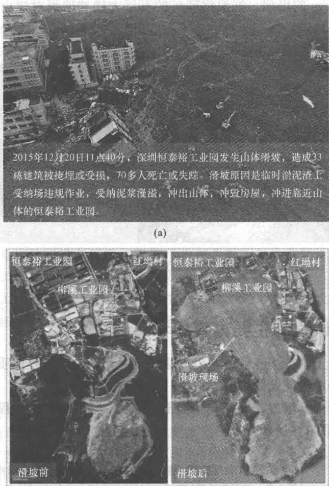
图 1-2 人为因素引起的山体滑坡 (a) 滑坡现场；(b) 滑坡前后影像对比
