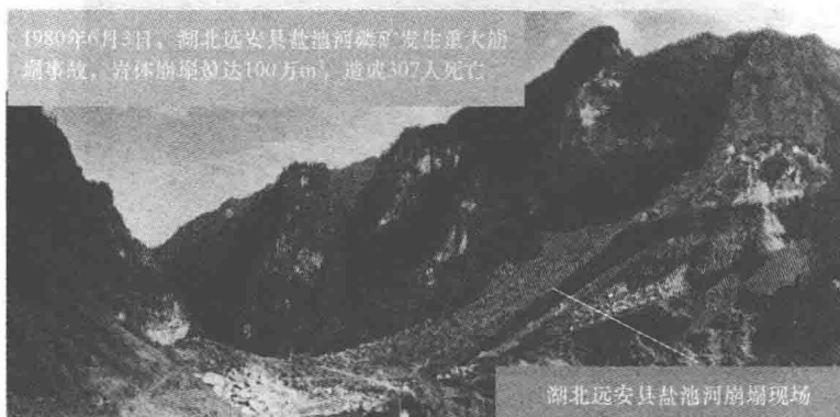
图 1-3 湖北远安县盐池河崩塌
