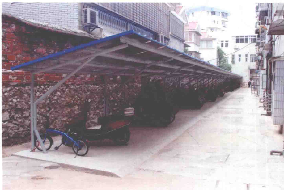
开展老旧小区改造——改造前后的鱼峰区柳电小区
