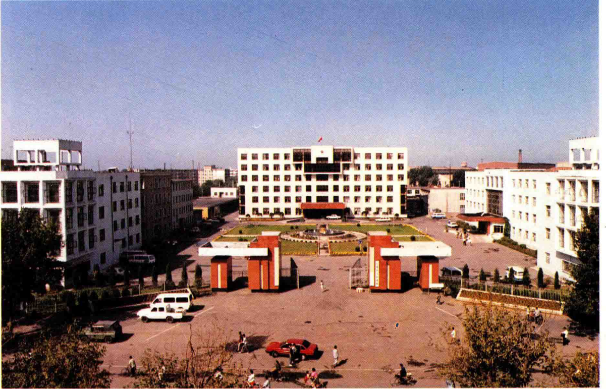
市政府办公楼
