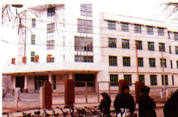
辽阳市白塔区解放小学
