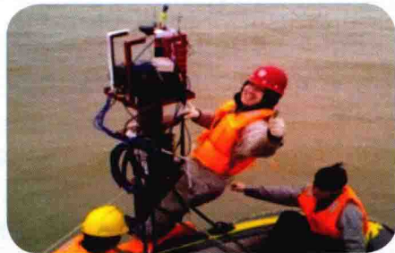
图 10 海上构筑物自动监测技术 （长江口深水航道治理二期工程）
