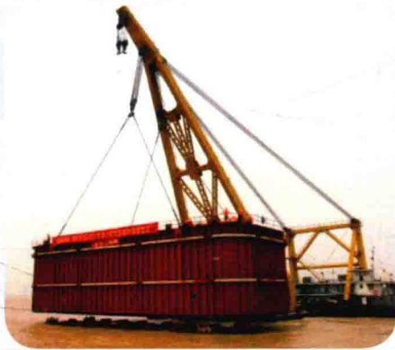
图 12 吊箱围堰
