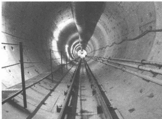
(a) 单洞单线外径6200mm盾构区间
