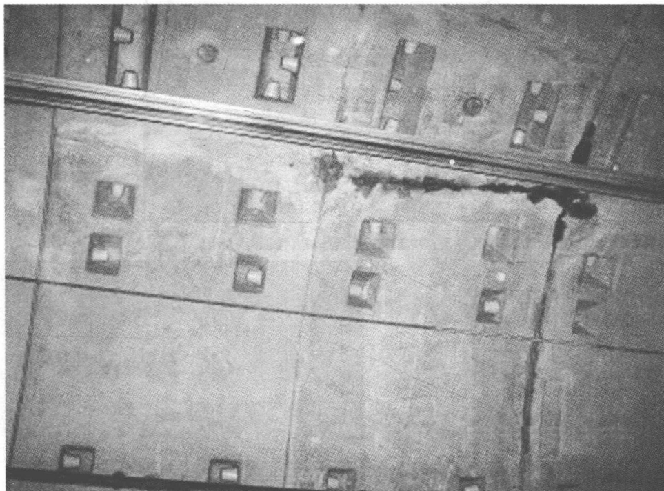
(a) 通缝拼装的盾构隧道
