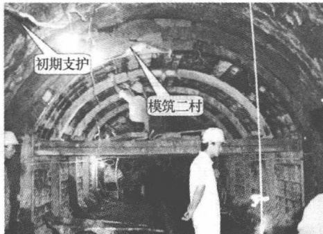
(a) 矿山法结构模板台车施工二衬现场照片
