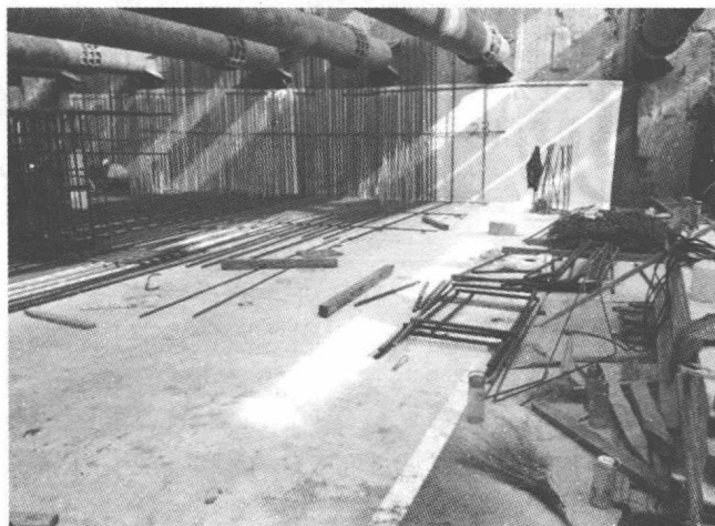
(a) 复合式衬砌明挖结构
