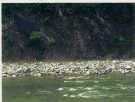
图 5-32 寒水沟栈道现状
