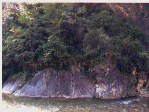
图 5-4 大北沟栈道现状
