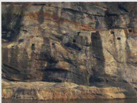
图 5-24 王八砭栈道遗址现状
