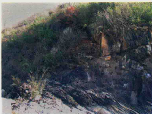
图 5-27 堰儿岩栈道遗址现状
