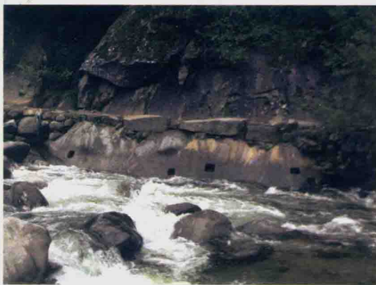
图 5-1 田坝栈道遗址现状
