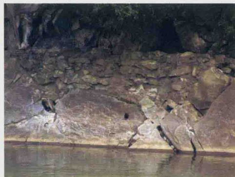
图 5-11 东河口栈道栈孔
