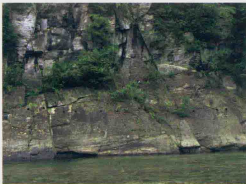
图 5-16 谭家坪栈道现状
