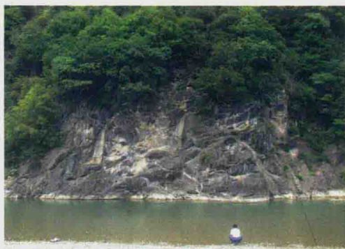
图 5-37 磨桥湾栈道现状
