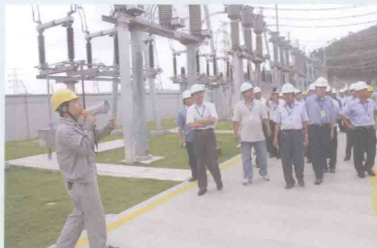
电网发展实现新跨越，惠州电网第一百座变电站110千伏洋纳站
