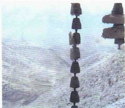
图 1-8 2008 年冰灾期间江城线 1718 号塔绝缘子掉串
