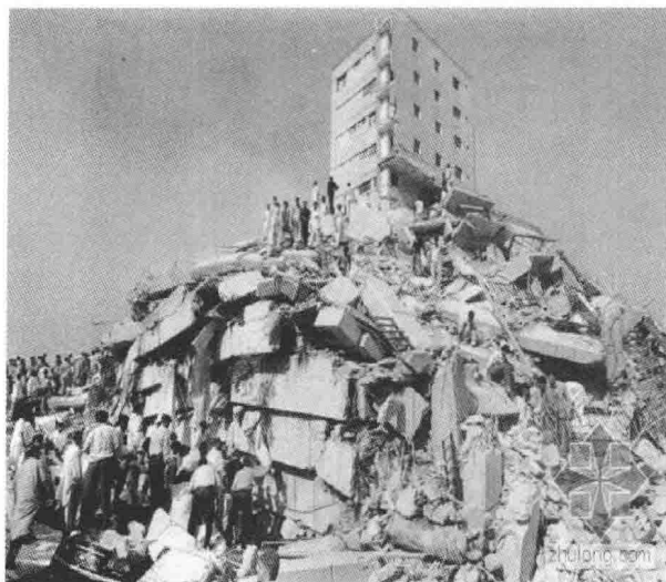
图 0-10 汶川地震中倒塌的房屋
