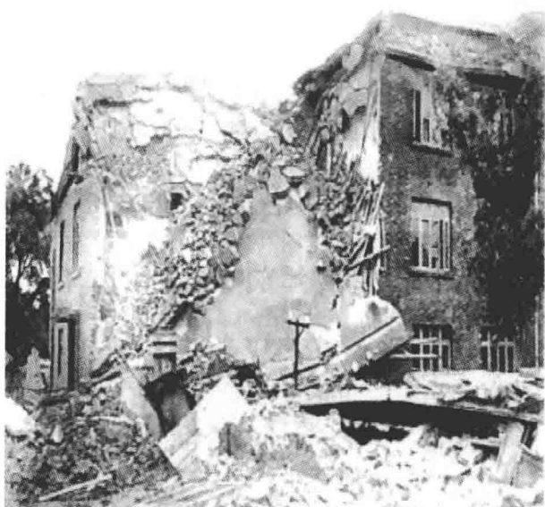
图 0-3 唐山地震倒塌的砖混结构办公楼
