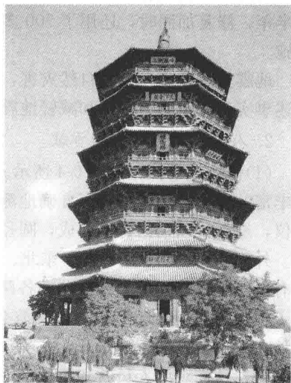
图 0-6 山西应县木塔
