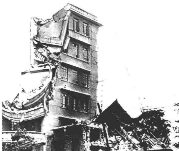
图 0-2 唐山地震倒塌的开滦煤矿医院
