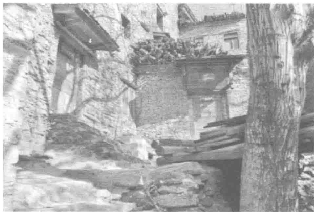
图1 石材、黄泥和木材营建而成的羌居
