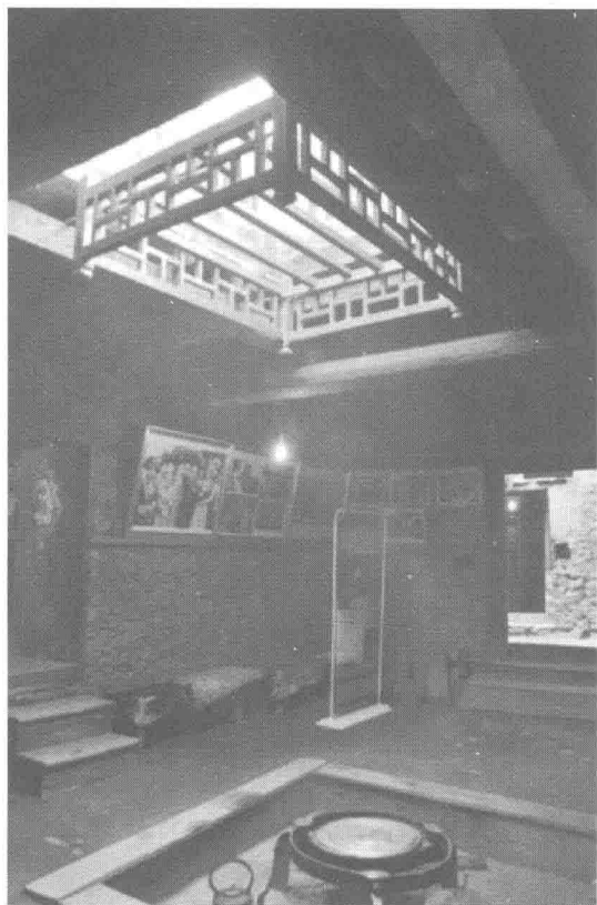
图7 主屋中的火塘上方的挂火炕
