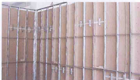
图1-6 铝合金龙骨隔墙
