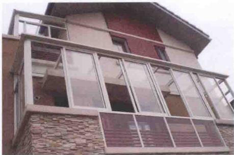
图1-8 塑钢封阳台
