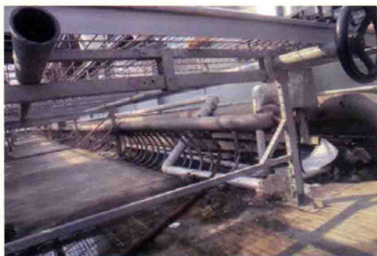
图 9-9 地源热泵加热系统中铺设的地热管
