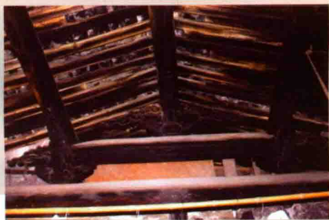
游寿故居《炳烛斋》前座保存的明代斗拱雕梁的木结构。
