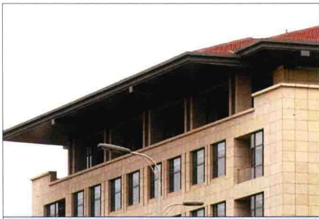
图 22 悬挑混凝土屋面完成效果
