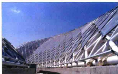
图 14 球铰夹具幕墙安装过程 (1)
