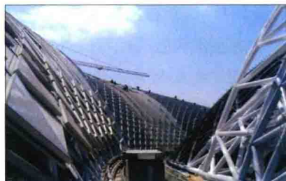
图 15 球铰夹具幕墙安装过程 (2)
