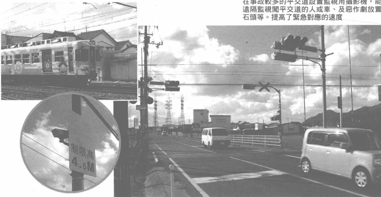
圖2 利用較少人數的效率化監視 日本一畑電車導入的平交道監視系統
