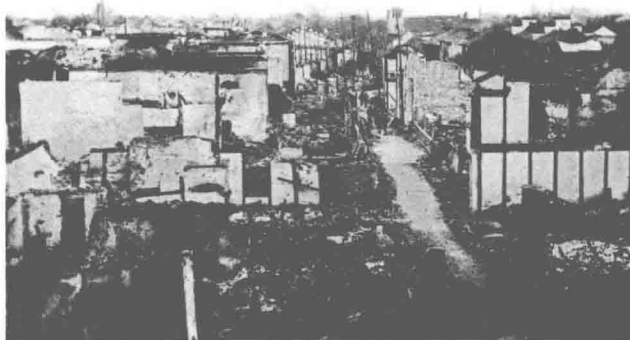
被破坏后的松江城内
