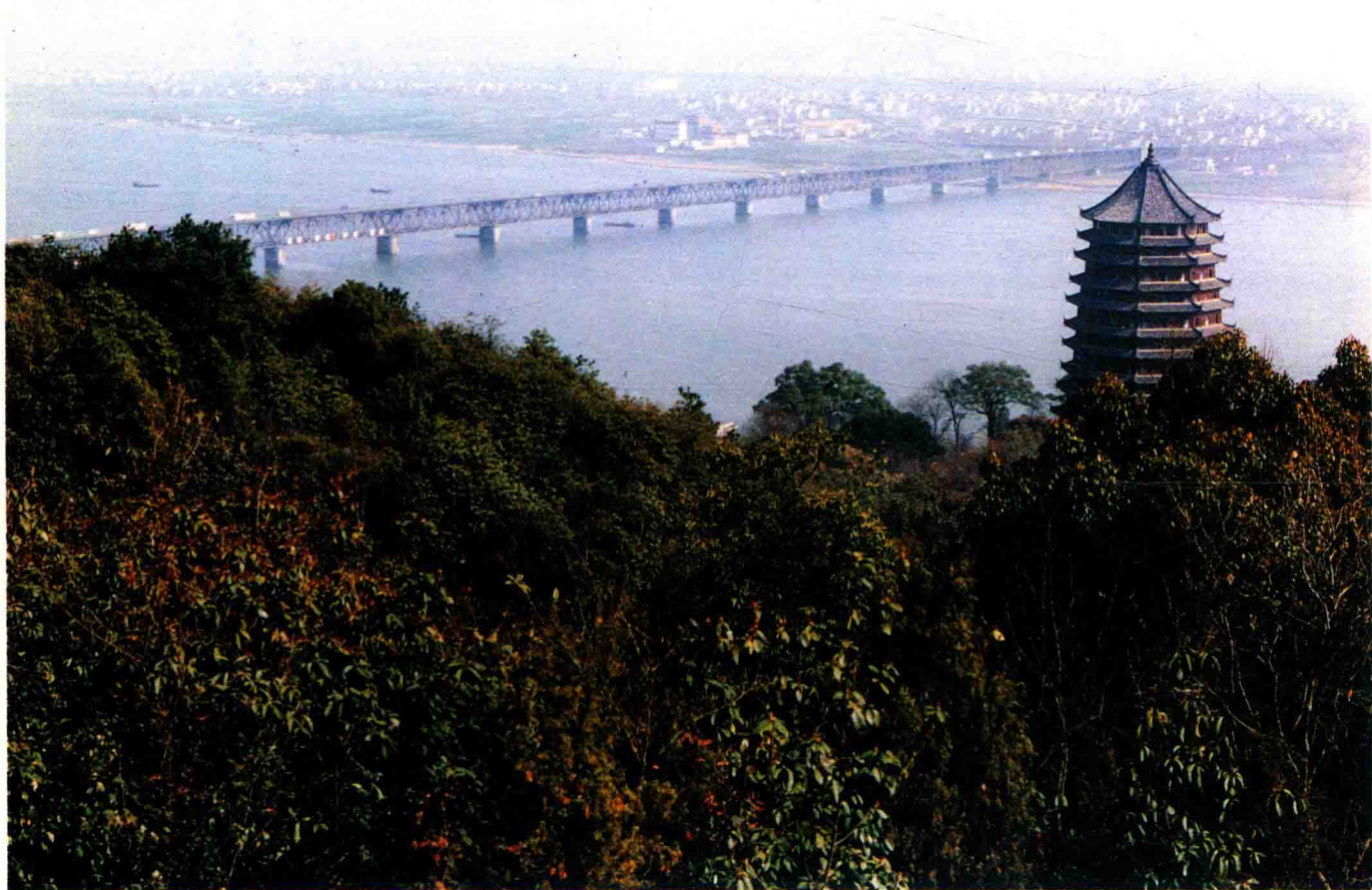
图 1-3 位于六和塔下的钱塘江既有桥全景
