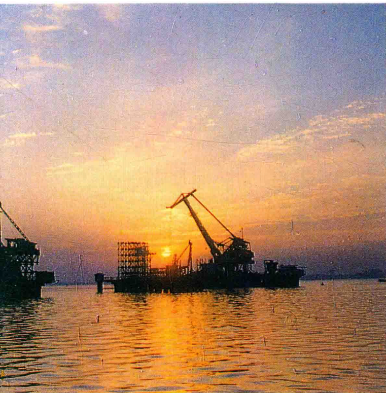
图 1-9 晨曦中的工程前期施工场景
