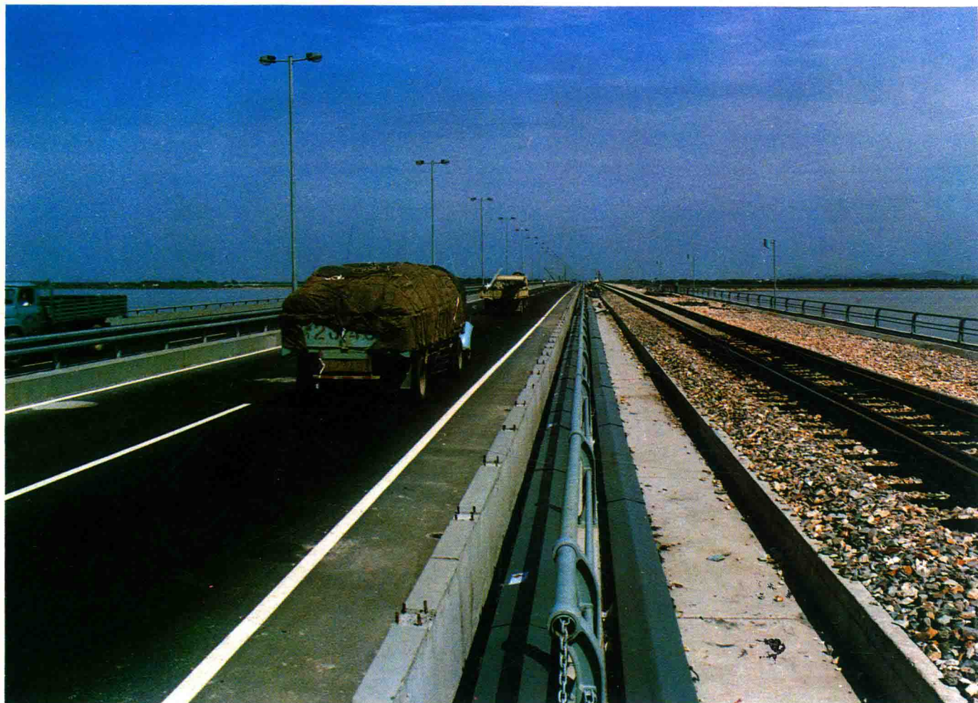
图 1-1 钱江二桥建成后桥面情况。铁路近期铺设单线,后期增铺第二线
