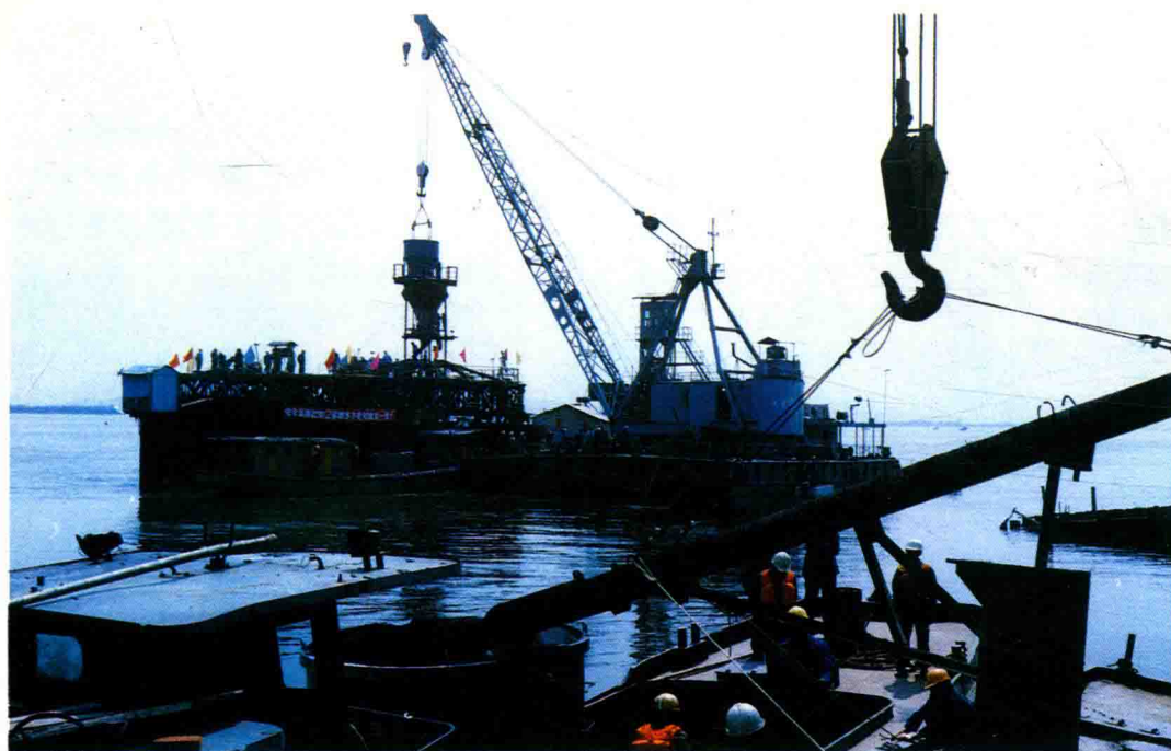
图 1-8 正桥 2 号墩开工
