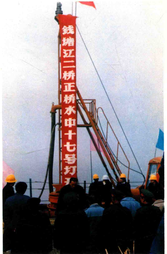
图 1-10 正桥 17 号墩开工
