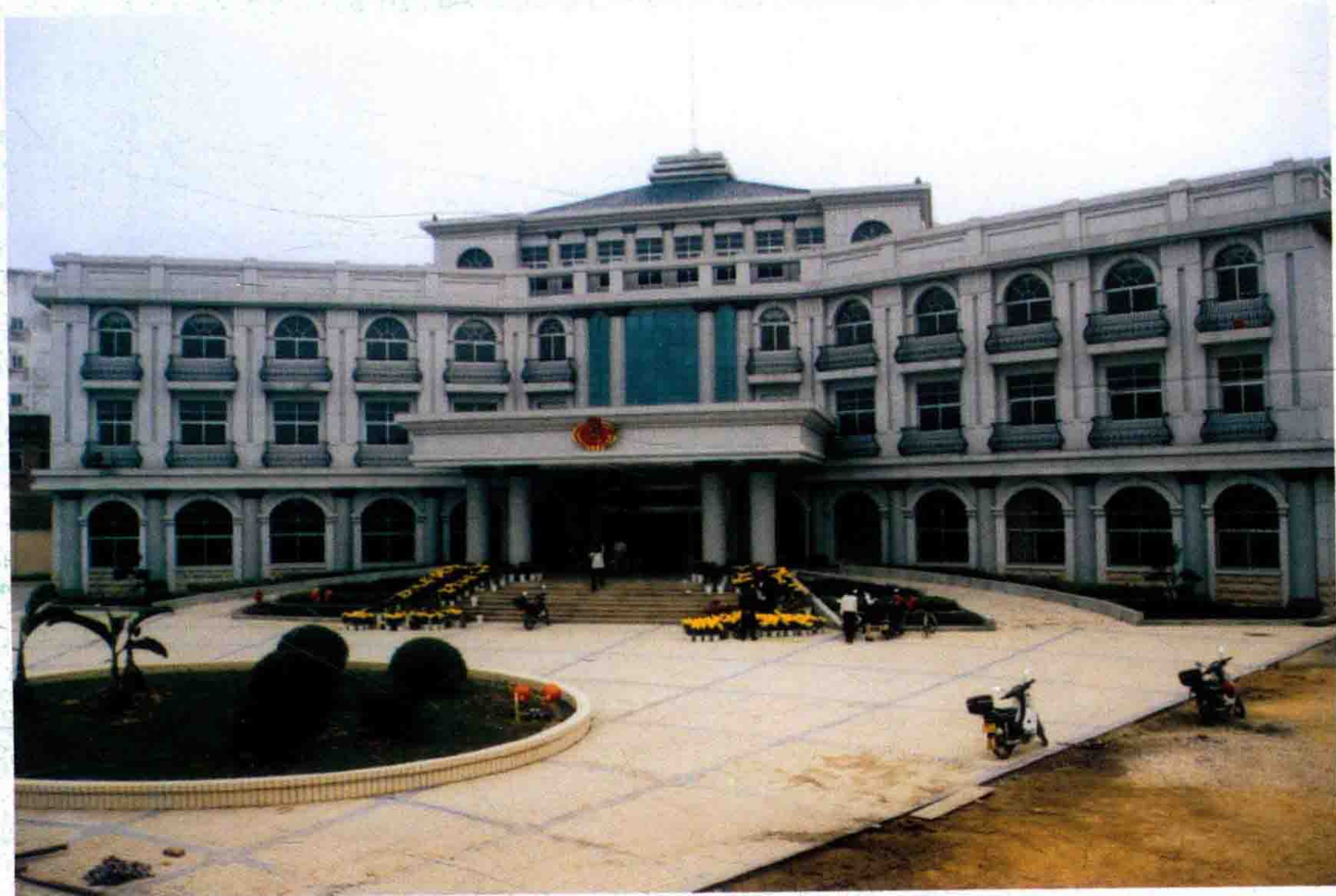
▲ 陆川县国家税务局新建办公楼
