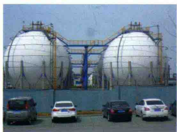
图 85 两球罐连通的水平钢梯
