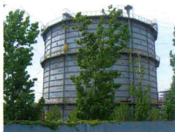
图 84 带加强立筋的贮罐
