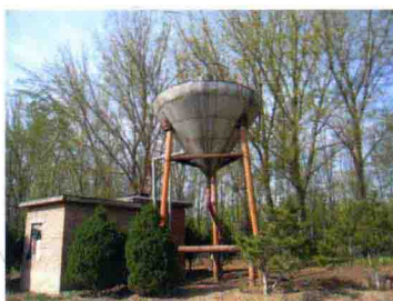
图 20 锥形拱顶贮水塔
