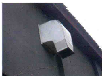
图 22 异径方弯管
