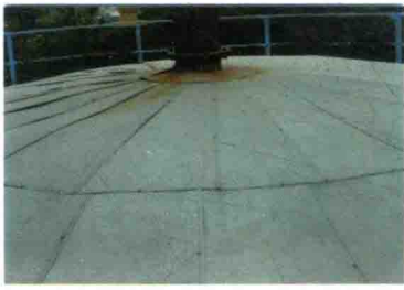
图 91 绝热后拱顶盖
