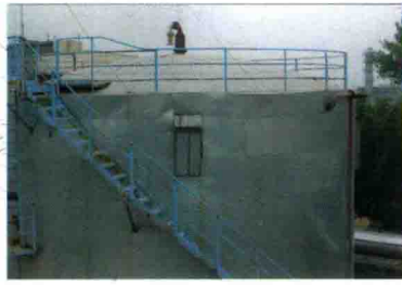
图 92 圆罐螺旋盘梯
