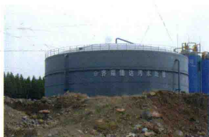
图 81 污水处理拱顶罐
