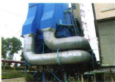
图 89 绝热后方圆排烟管
