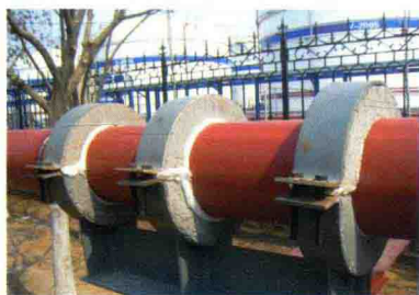
图 79 管道法兰绝热
