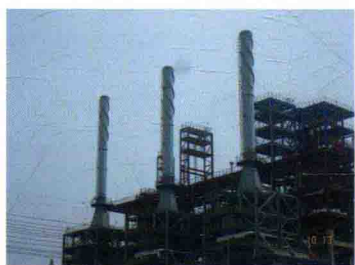
图 82 外带螺旋立板的烟囱
