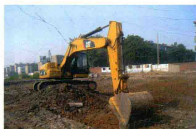
图 54 挖土机正在工作
