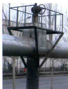
图 13 水平管道阀门绝热
