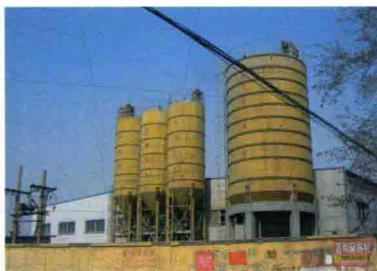
图 71 带加强筋的贮罐
