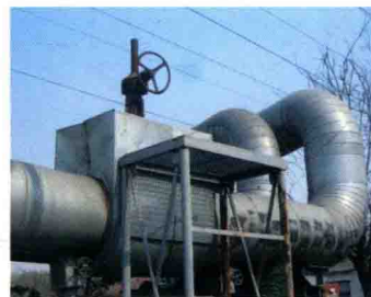
图 72 水平管道阀门绝热
