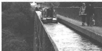
图 1-2 庞特吉西斯特高架水道桥
