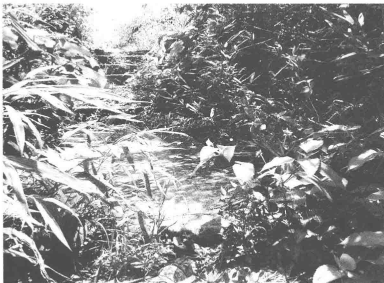
旧时的黔桂古道。路面宽约 1.2 米，多用不规则的片石、条石铺就。据传始建于汉代，拓宽于唐朝。毛南山乡的一段有关隘九处，均用巨石砌成。旧《思恩县志》记载，民国十年以前往返黔桂的商旅悉经此道。（覃自昆供图）
