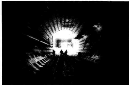
图 1-6 装配式圆形管片结构
