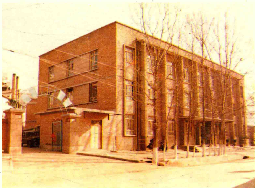
陕西省石油公司铜川分公司办公楼
