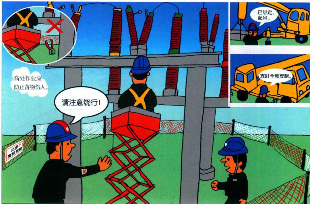
**控制措施一：**高处作业应使用工具袋。较大的工具应用绳索拴在牢固的构件上，工件、边角余料应放置可靠，采取防坠措施，不得随便乱放，以防止从高处掉落伤人。禁止将工具及材料上下投掷，应用绳索拴牢传递，以免打伤下方工作人员或击毁脚手架。
