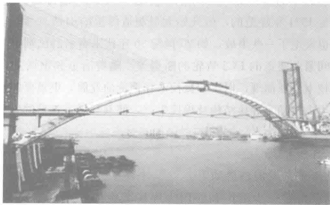
图0-1 上海卢浦大桥
