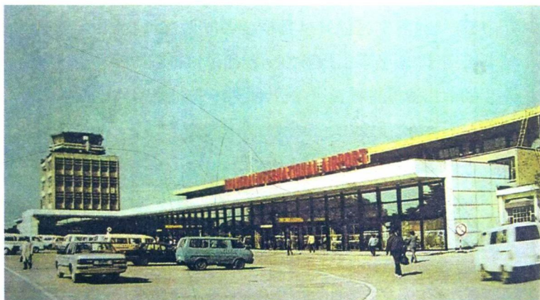
图 1-4 1984 年扩建完成的旅客航站楼
