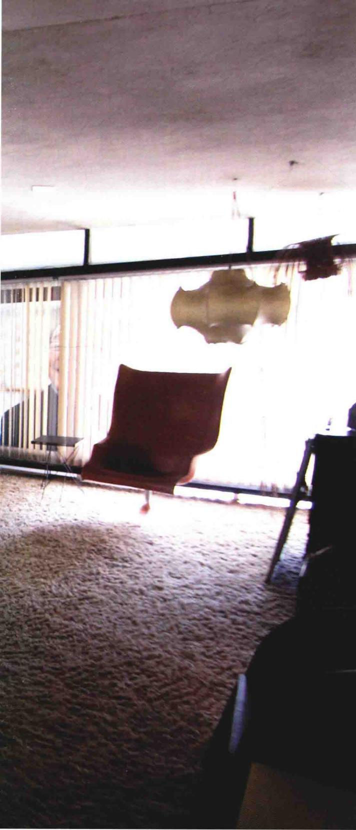
4 根立柱支承着浮在半空中的楼板。四周是像阳台一样的回廊，外侧的木制防雨门与内侧的玻璃拉门形成双重表皮，包围着室内空间。上方铺设贝壳形混凝土曲面天花板，下方是 4 间<sup>1</sup> 大的正方形独立空间（7.2 米 × 7.2 米），既没有梁柱，也没有墙壁。
