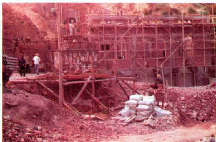
施工中的西达水电站厂房
