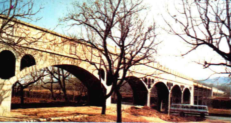
青塔水库干渠 尖饼窑渡槽
