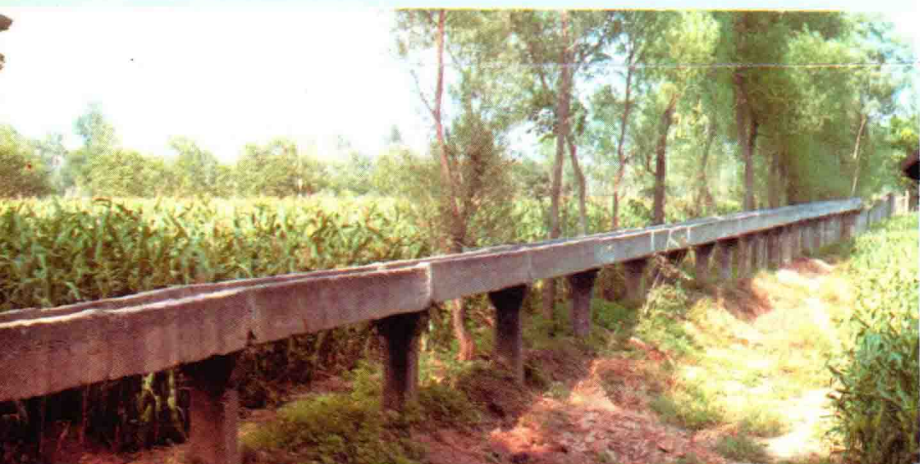
沿头村机井渡槽
