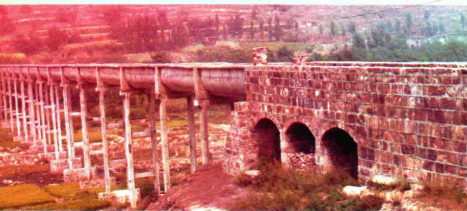
漳西渠茅岭底渡槽
