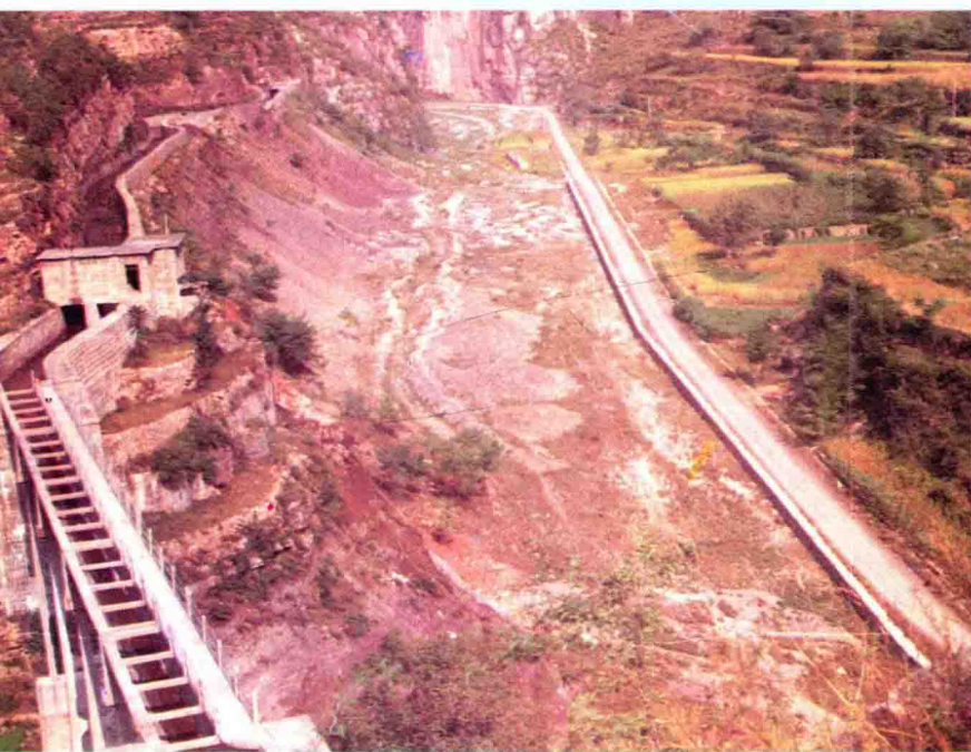
青塔水库干渠二号渡槽
