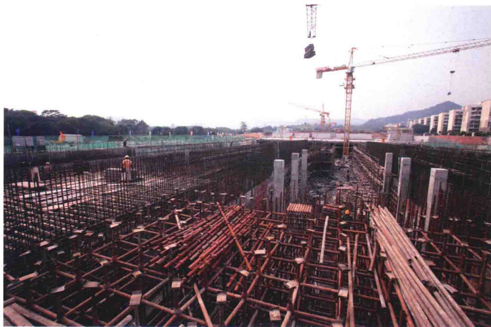
施工中的地铁中心公园停车场主体结构(四)
