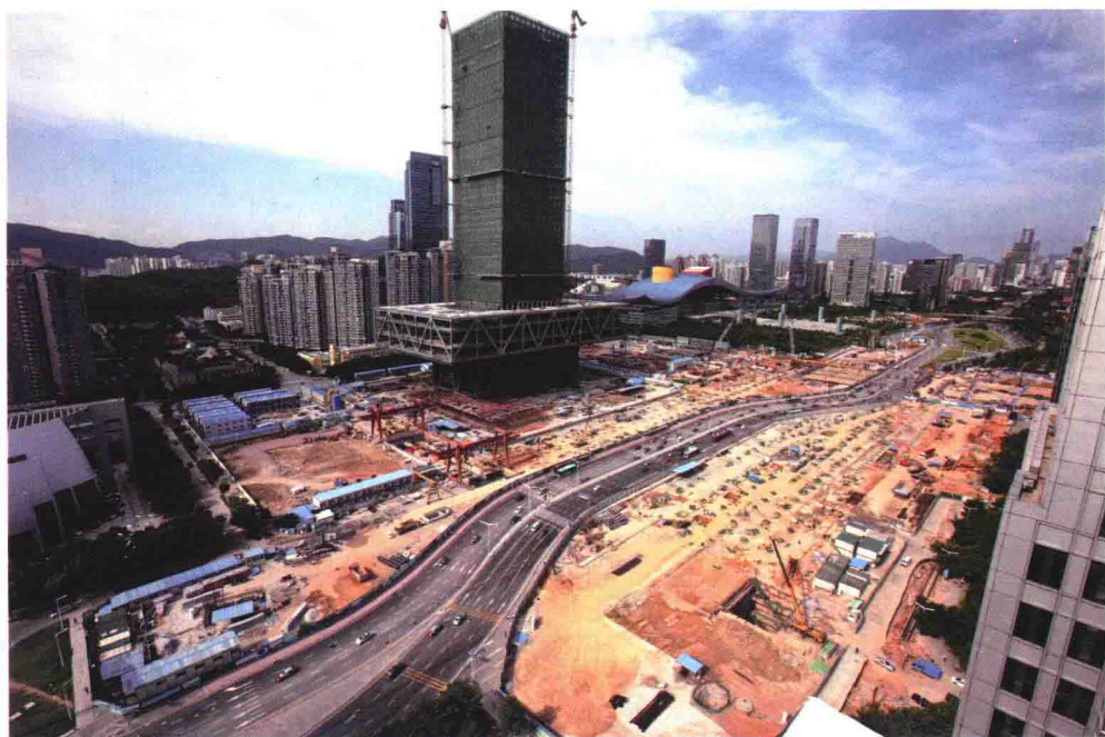
福田枢纽工地
