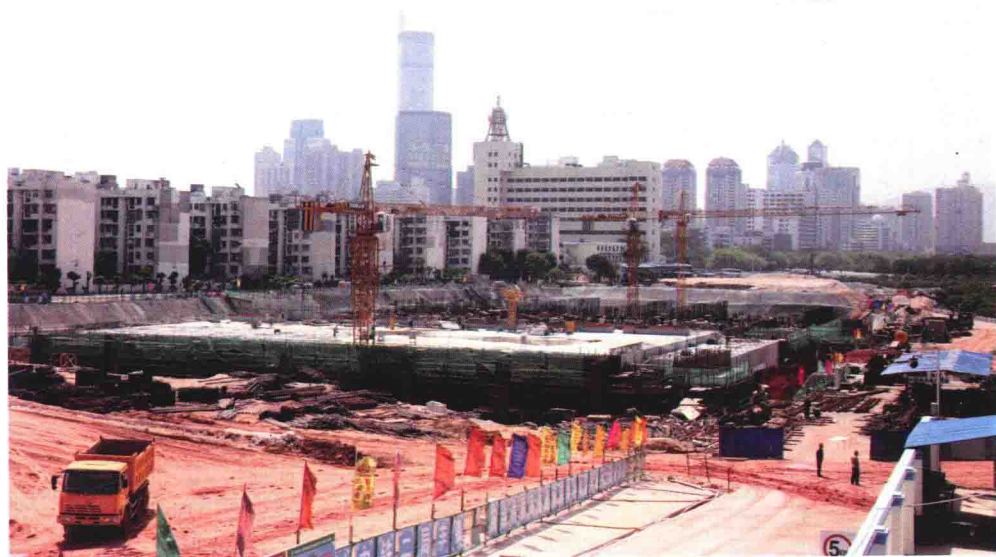
施工中的地铁中心公园停车场主体结构(一)
