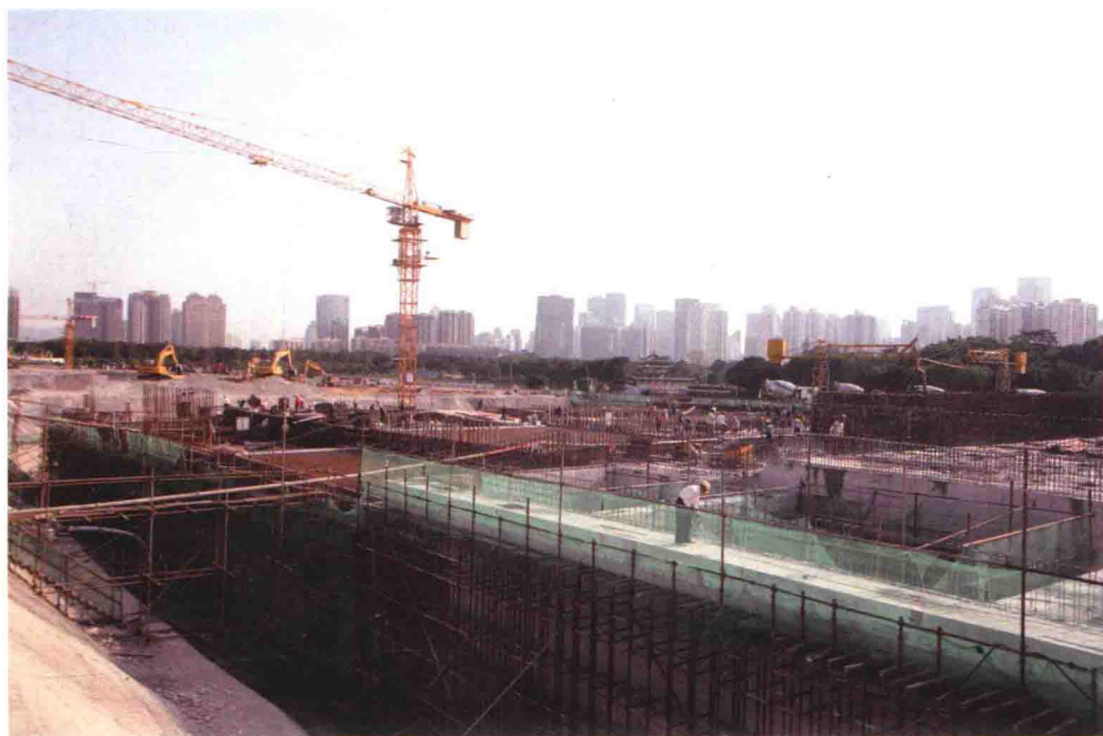
施工中的地铁中心公园停车场主体结构(二)
