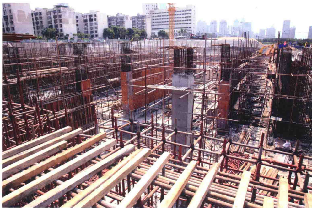
施工中的地铁中心公园停车场主体结构(五)
