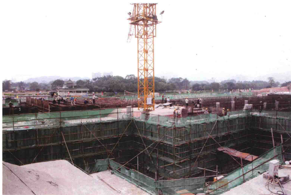
施工中的地铁中心公园停车场主体结构(三)
