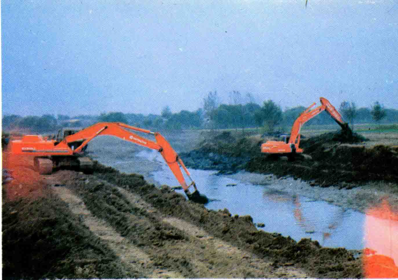
→ 机械清淤现场 (商克智摄)
