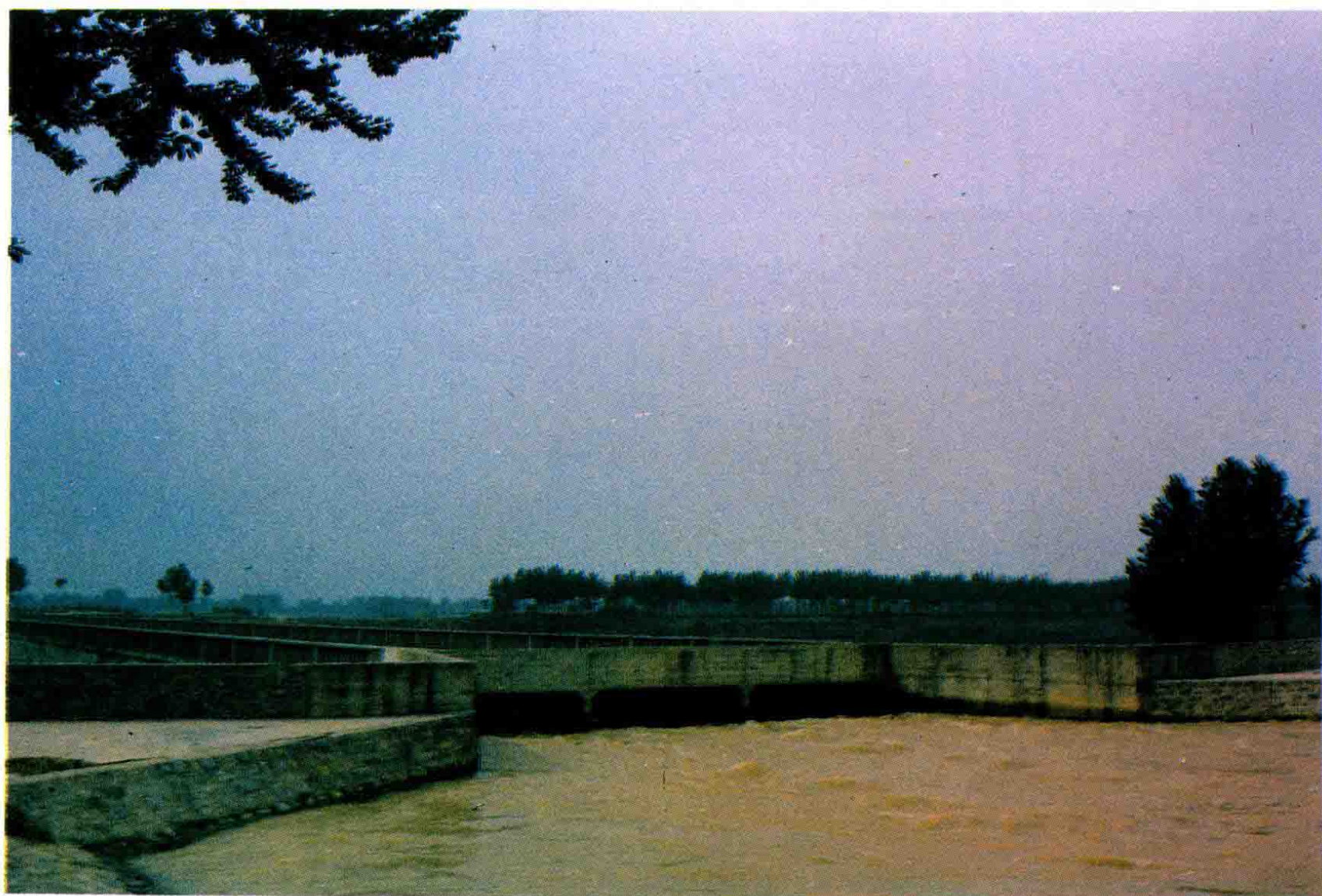
↑李家岸引黄总干渠跨徒骇河官家渡槽
