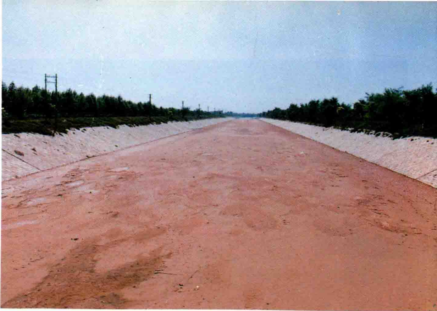
→ 潘庄引黄灌区总干渠衬砌 (卞锡华摄)
