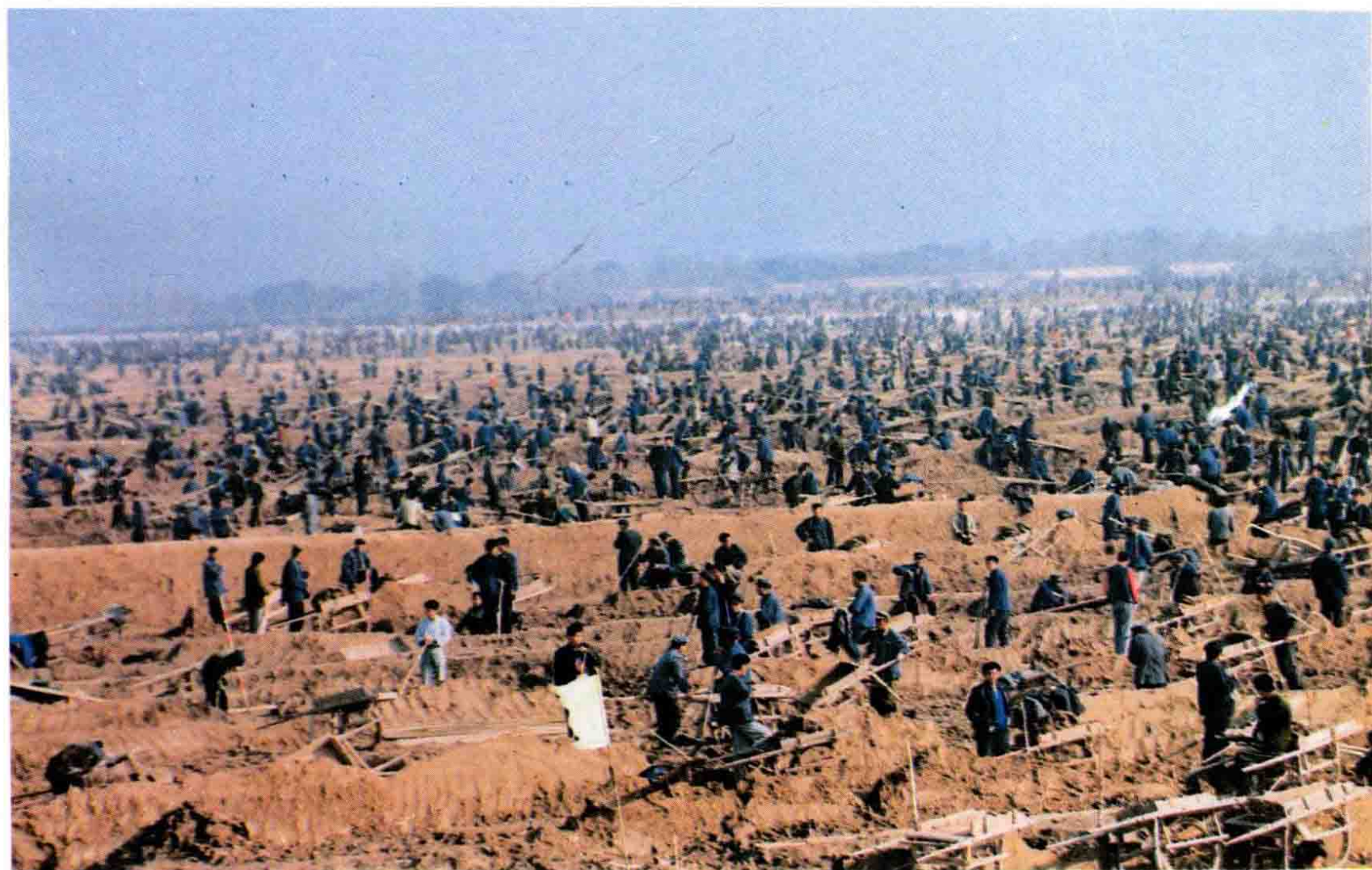
↑引黄清淤工程施工现场
