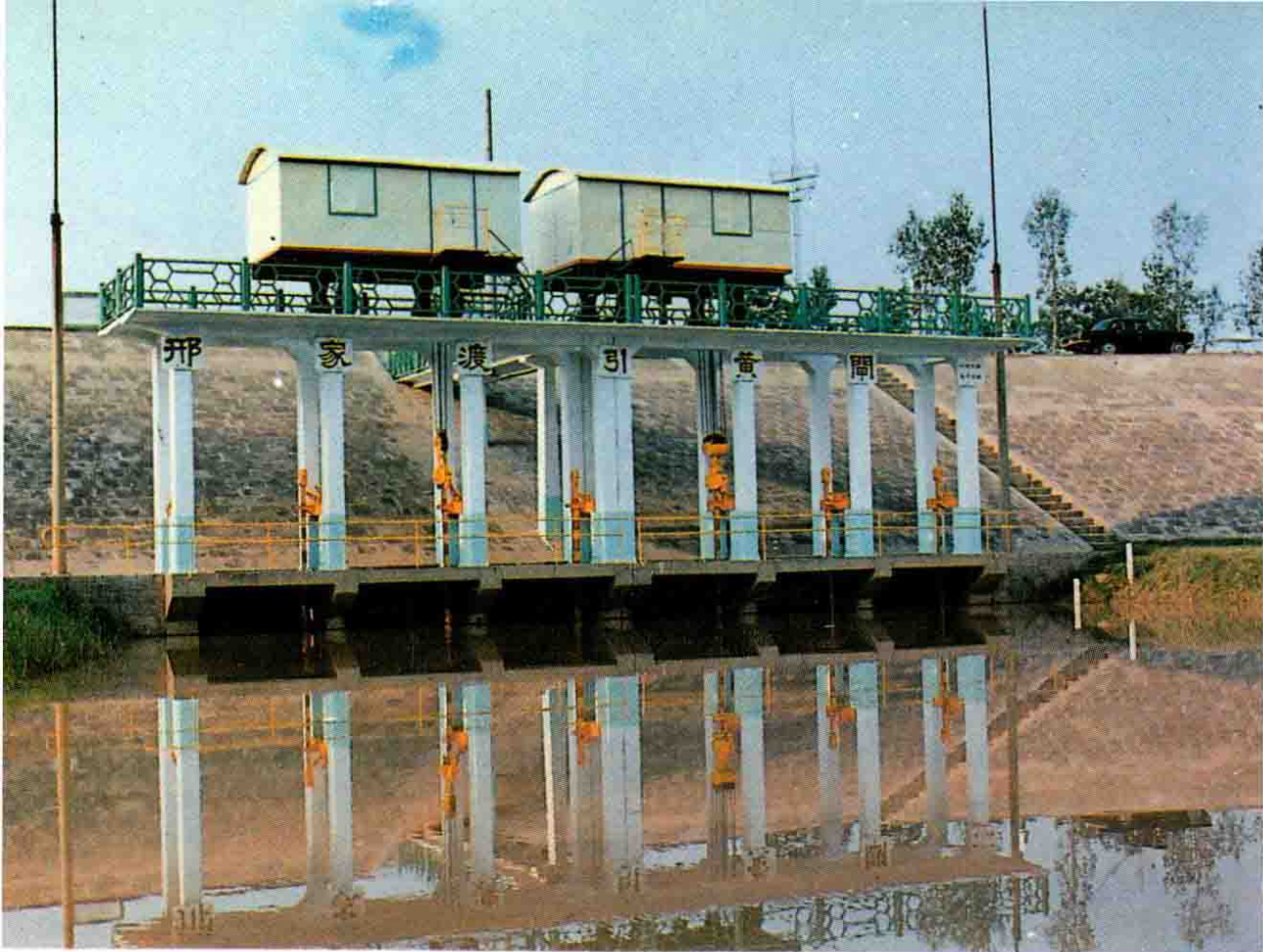
← 邢家渡引黄闸 (济阳县水利局提供)
