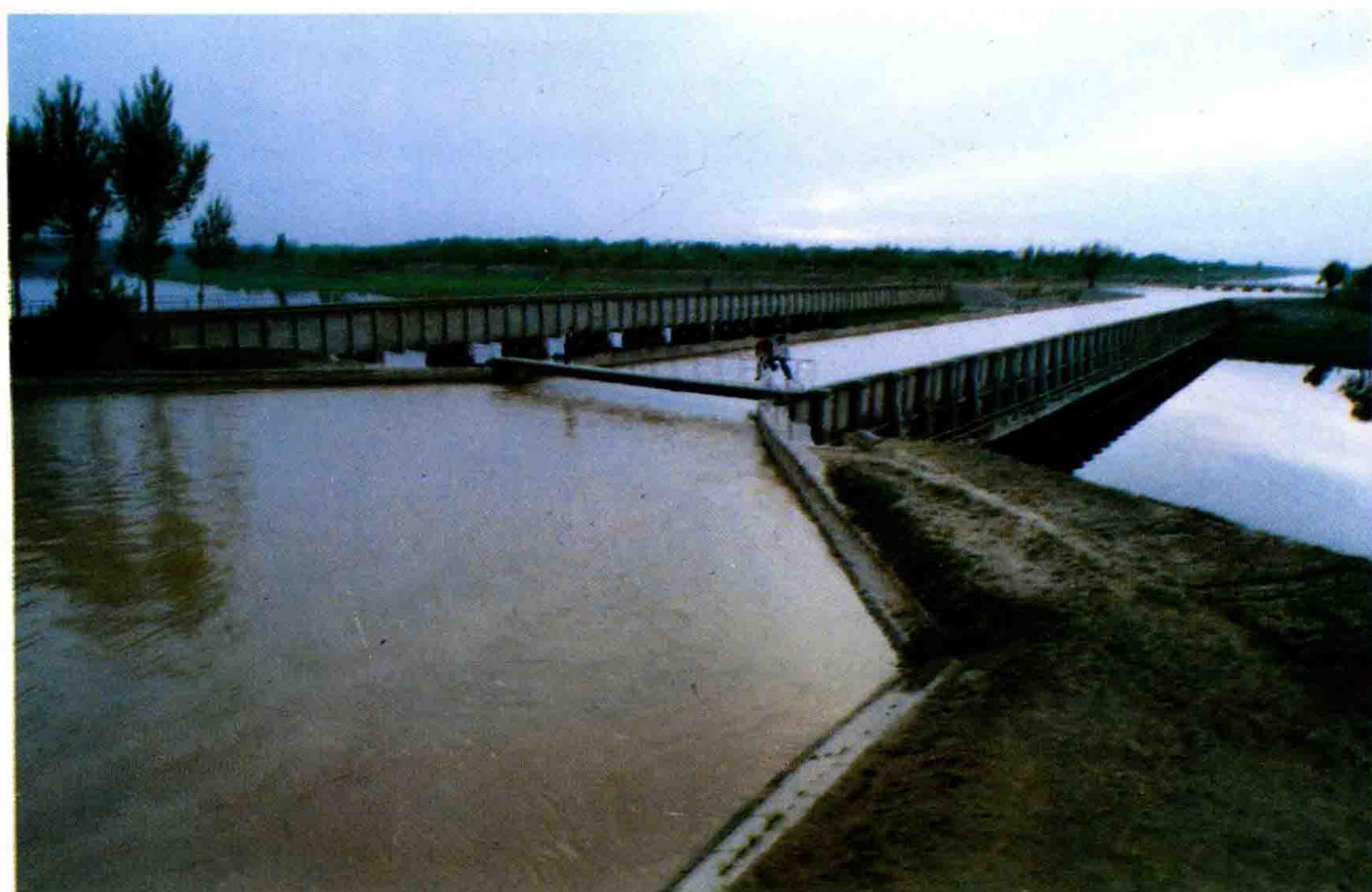
↑潘庄引黄总干渠跨徒骇河武庄渡槽
