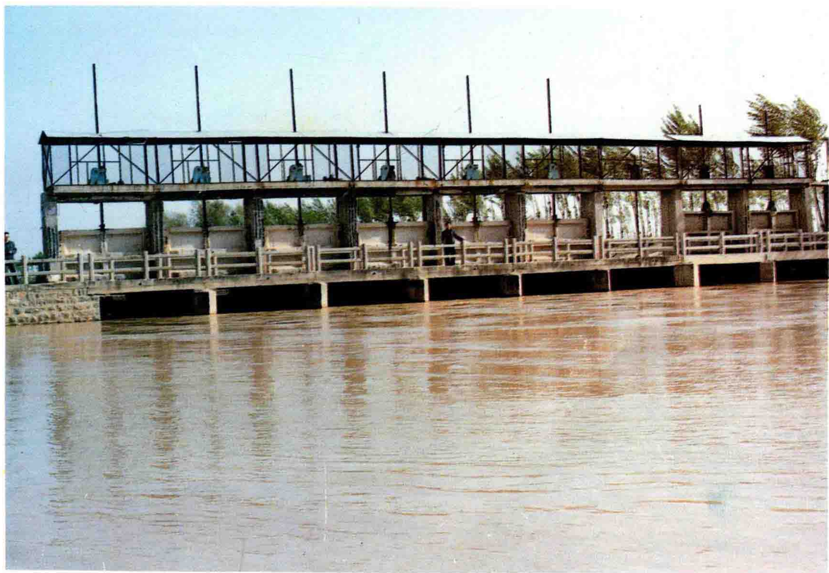
↑ 潘庄引黄总干渠崔庄闸
