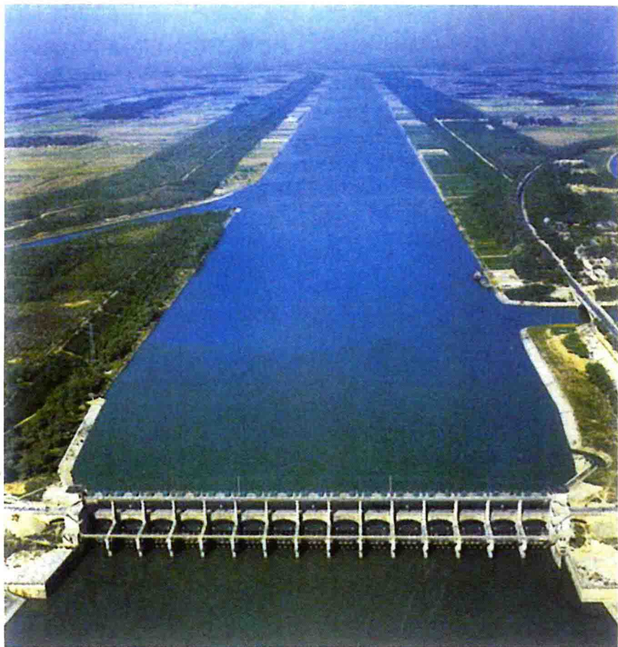
1968 年建新汴河宿州闸。闸南面另建有通行船只的复闸
