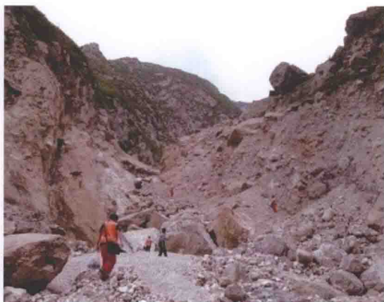
(b)泥石流引起的沟道堵塞
