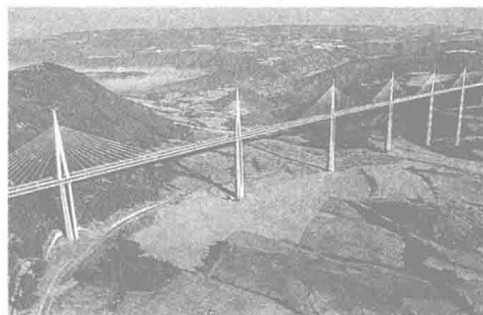
图 1-14 法国米劳大桥
