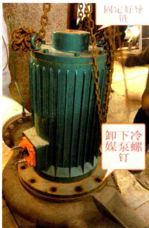
图8-14 冷媒泵螺钉卸下，把导链支好（156页）
