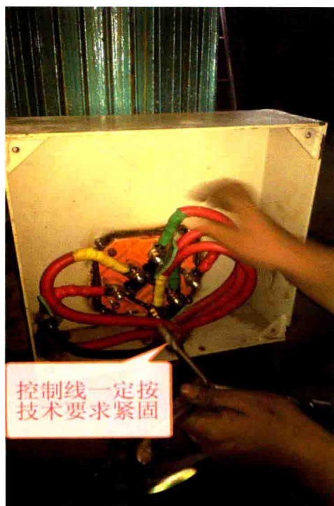
图8-16 控制线特硬，按技术要求紧固（156页）
