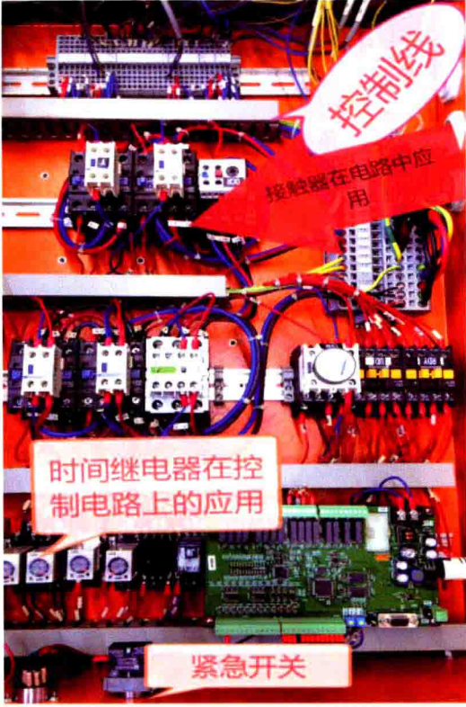
图5-16 时间继电器在电路中的应用（71页）
