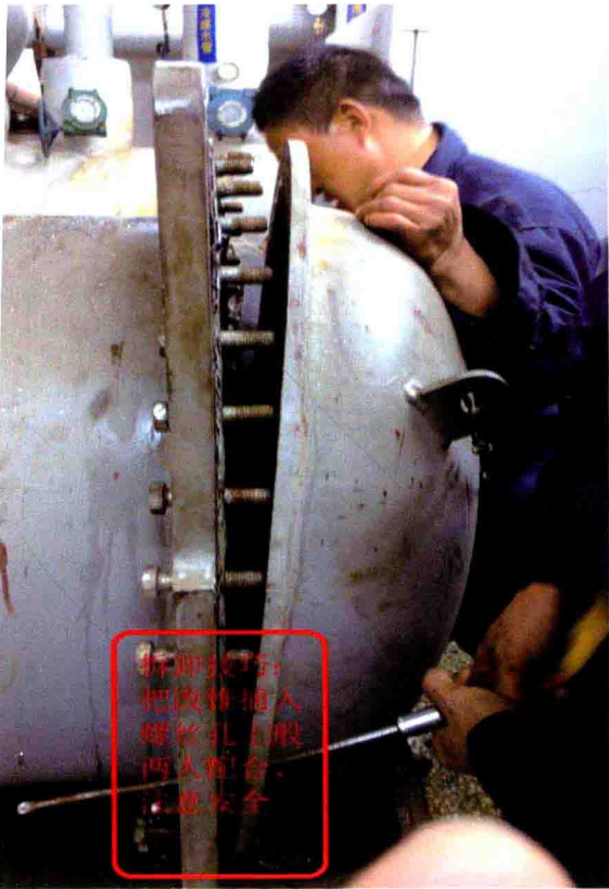
图3-4 冷凝器漏——制冷剂拆卸封盖方法（37页）
