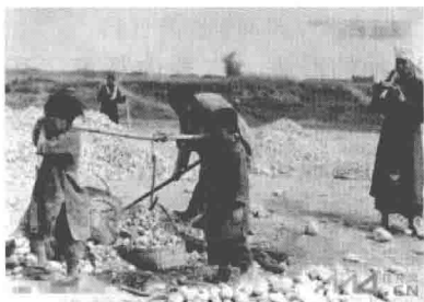
图 1-7 旧照片中瓦工 搬运地基毛石情景
