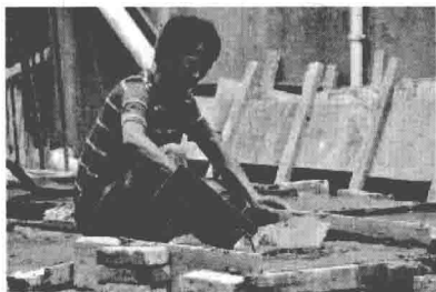
图 1-5 旧照片中瓦工砌墙情景
