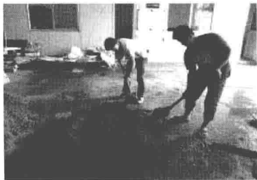
图 1-6 瓦工搅拌水泥情景
