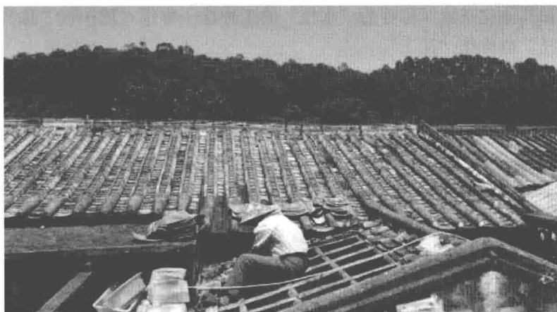
图 1-9 瓦工在屋面铺瓦情景
