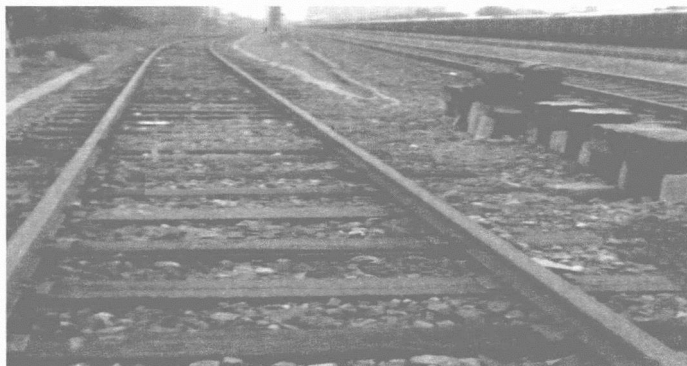
图 1-3 偶尔过车的钢轨轨面生锈
