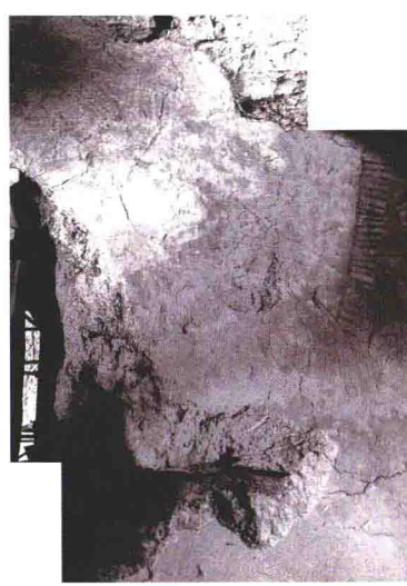
5. 中心柱后面南端上下部接合 （红外线〔处理〕）
