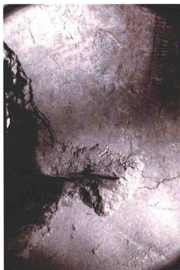
4. 中心柱后面南端下部 （红外线〔处理〕）
