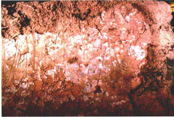
7. 中心柱后面的北端(可见光、红外线照片〔处理〕合成)
