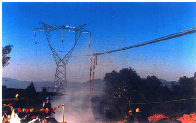
云南首条 500 千伏西 电东送大通道建设—— 500 千伏宝罗线首个区 段放线
