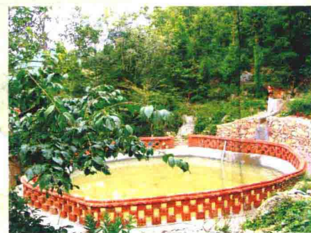
烟水配套有活水源的已蓄水之取水池
