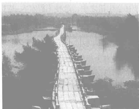
图 1-2 安平桥(公元 1138 年)
