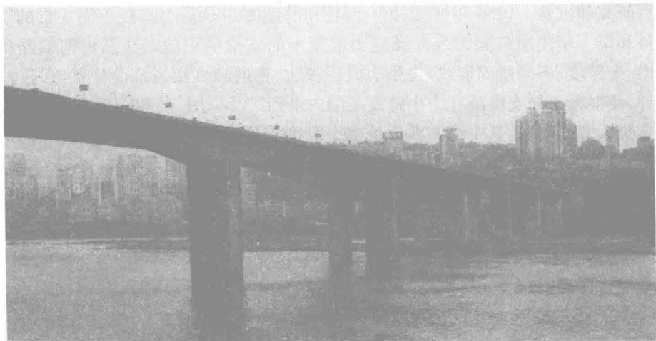
图 1-10 石板坡长江大桥(2006 年)
