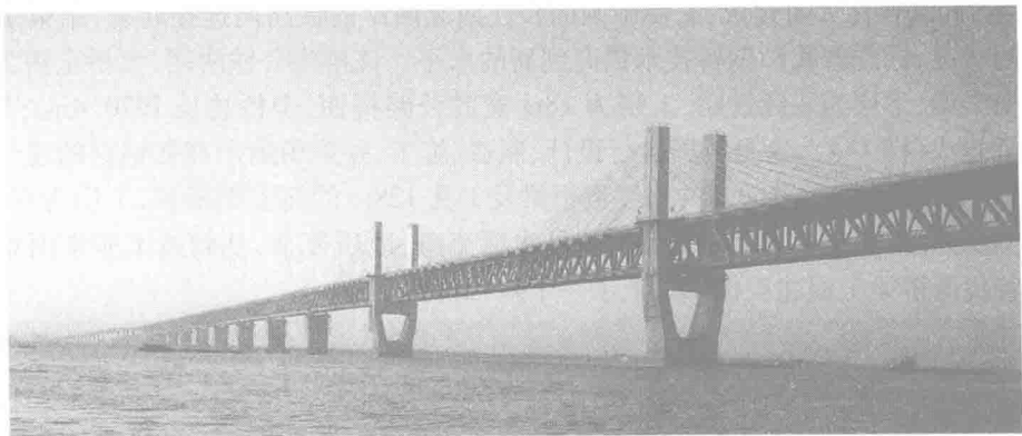
图 1-6 芜湖长江大桥(2000 年)
