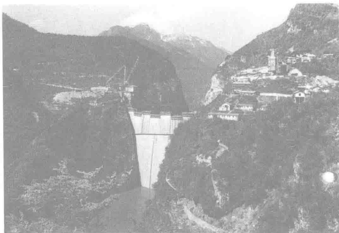
(a)建设中的瓦伊昂大坝
