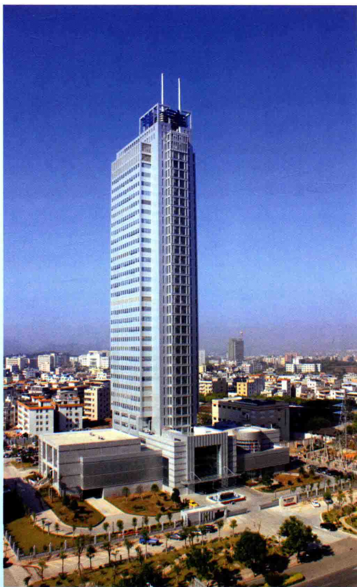
惠州供电局新大楼
