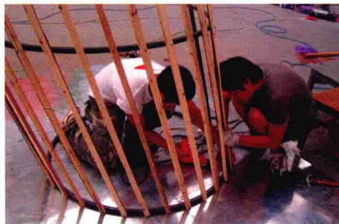
图3-8 两个男生共同协作完成钉龙骨的工作
